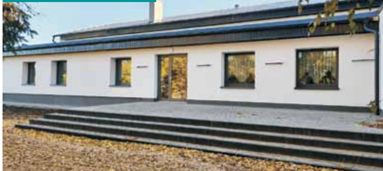
Jeden z modernizowanych obiektów
