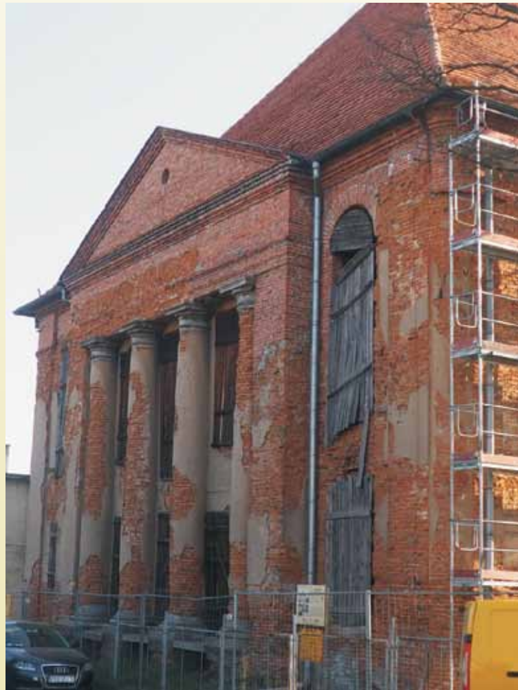
Synagoga w czasie remontu w 2023 r.
